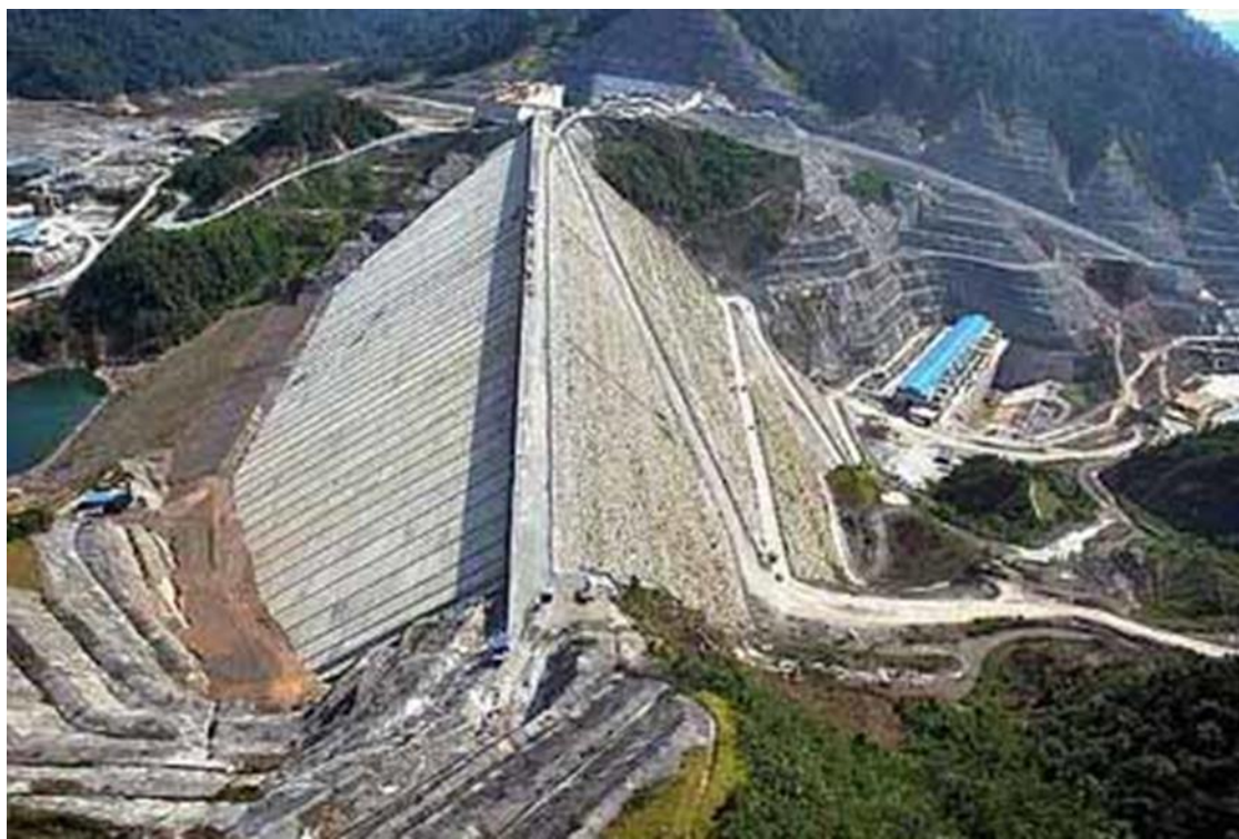
Figura 2.4. Barragem de Bakun, no curso do rio Balui, Malásia. A estrutura é um exemplo de barragem de enrocamento com face de concreto, ou Concrete Face Rock Dam (CFRD). Na foto, é possível observar a face de concreto voltada a montante e o enrocamento no talude de jusante (de Gordan & Adnan, 2017).
