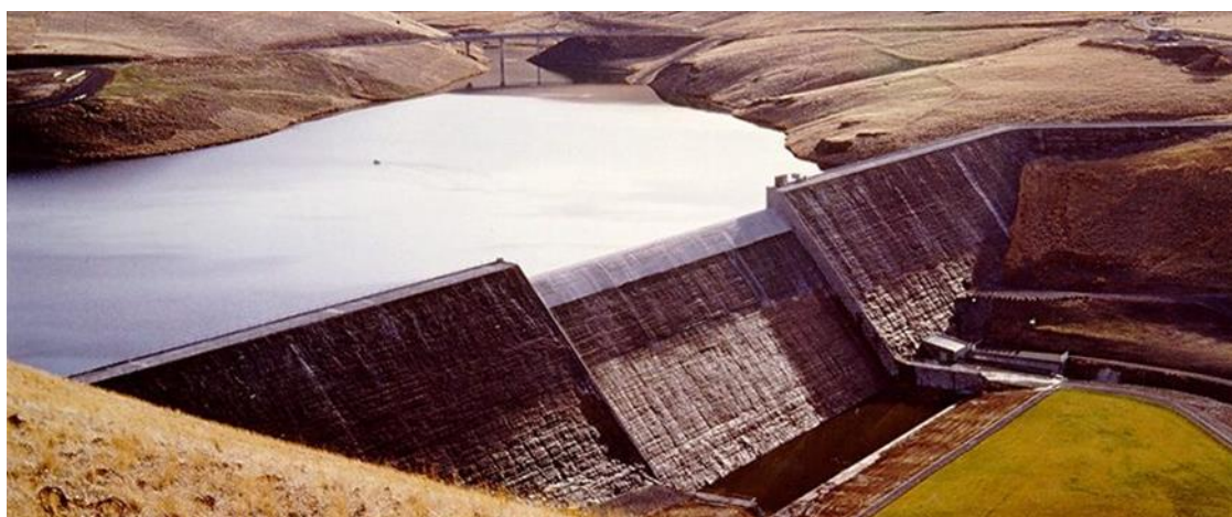
Figura 2.1. Barragem de Willow Creek, em Óregon (Estados Unidos), um exemplo de estrutura do tipo concreto-gravidade com alta estabilidade (de US Army Corps of Engineers, 2009).
