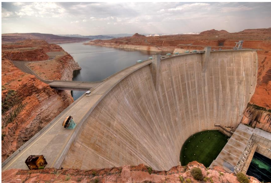
Figura 2.2. Barragem de Glen Canyon, no curso do rio Colorado, Arizona (Estados Unidos), um exemplo de estrutura em arco. Na figura, é possível observar o estreitamento do talvegue, muito profundo e inciso, além da estrutura de concreto engastada nas ombreiras, diretamente sobre o arenito da Formação Navajo, no vale do rio Colorado (de Vicente Villàmon, Flickr, 2009).
