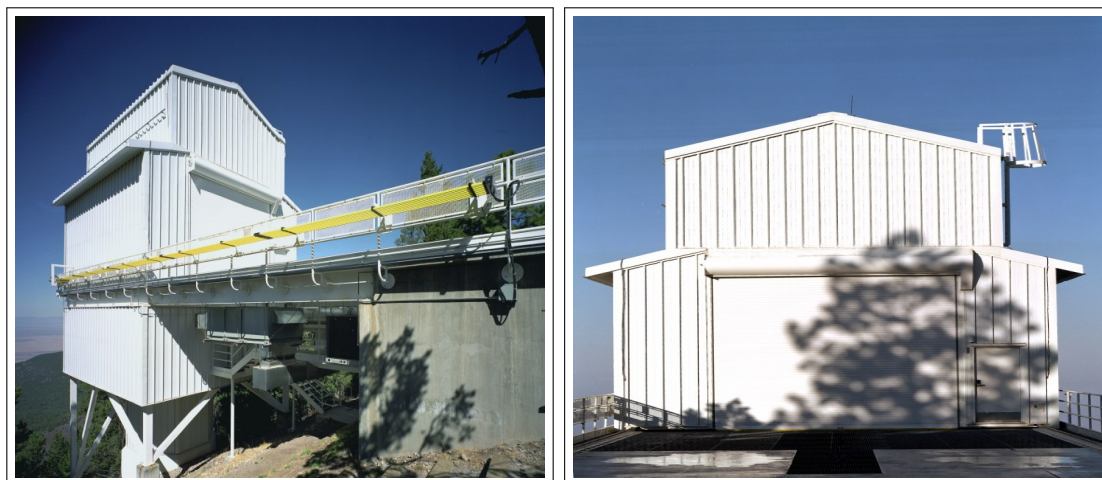
Figura 3.3: Estrutura de cobertura do telescópio. A figura da esquerda mostra a estrutura que protege o telescópio quando não está em uso. Já a figura da direita mostra essa mesma estrutura vista de frente. Fonte: http://www.sdss2.org/gallery/gal_photos.html
