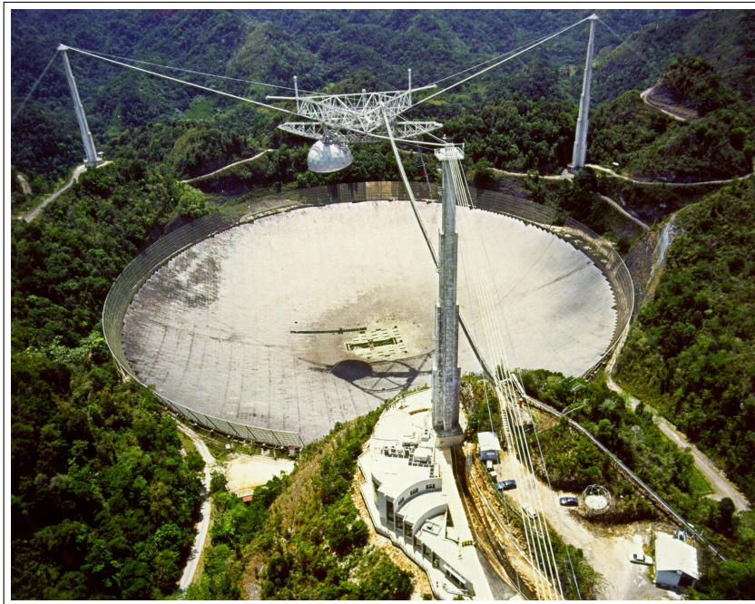
Figura 15: Radiotelescópio de Arecibo, localizado em Porto Rico. A antena possui um diâmetro de 305 m.
