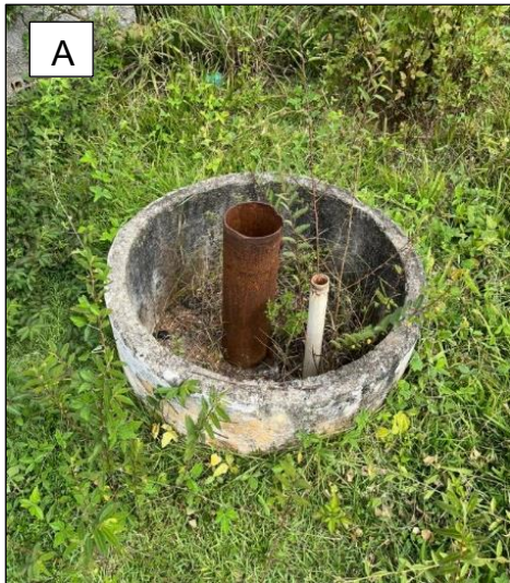
Figura 1 – Poço cadastrado com altos teores de urânio próximo ao Ginásio Municipal - Mário de Araújo Chaves desativado, porém não lacrado. Fonte: O autor.
