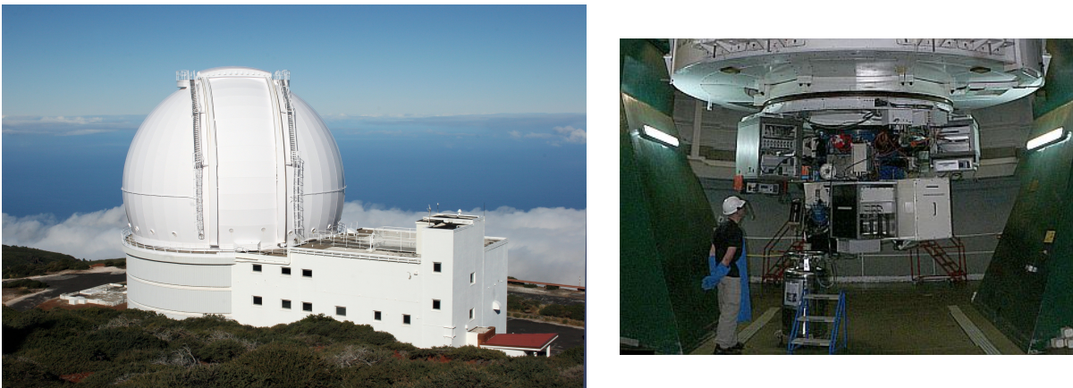
Figura 5.3: A Esquerda: Telescópio de 4.2 m William Herschel localizado nas ilhas Canárias, cujo tempo de observação está dedicado em um 70% ao levantamento WEAVE. A Direita: Montagem do espectrógrafo de braço duplo ISIS (Intermediate-dispersion Spectrograph Imaging System).
